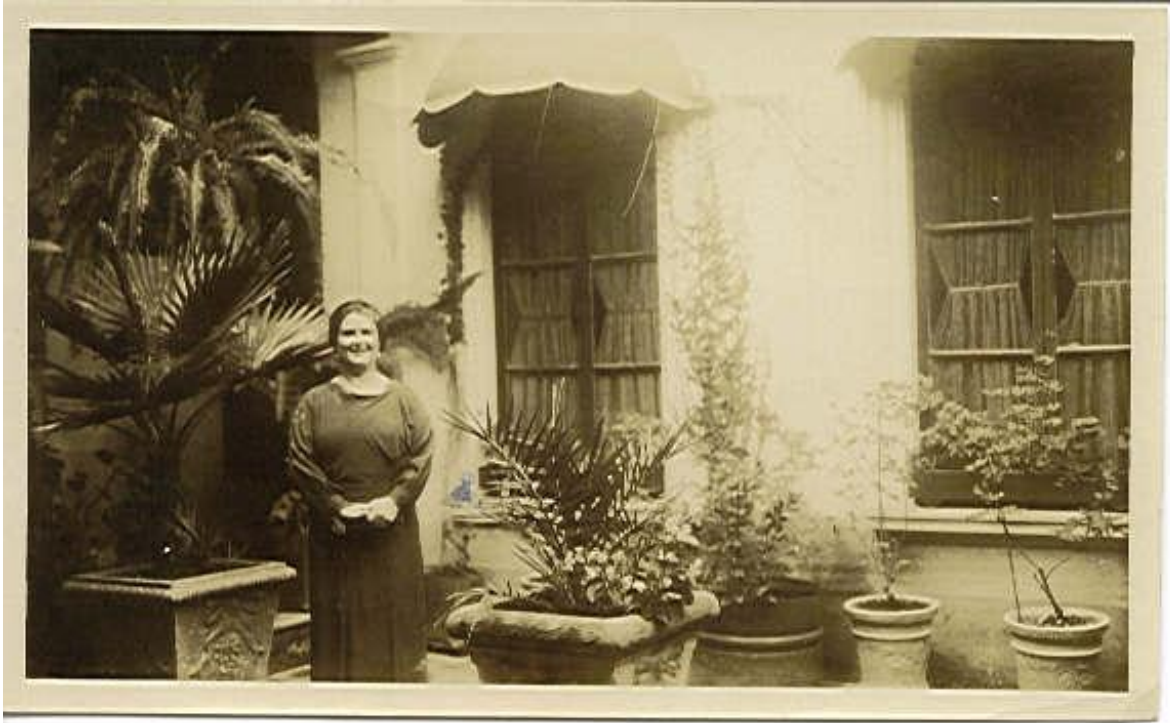
Casa de los esposos Valenti Doninelli (Casa No. 34, 9ª. Calle poniente)
